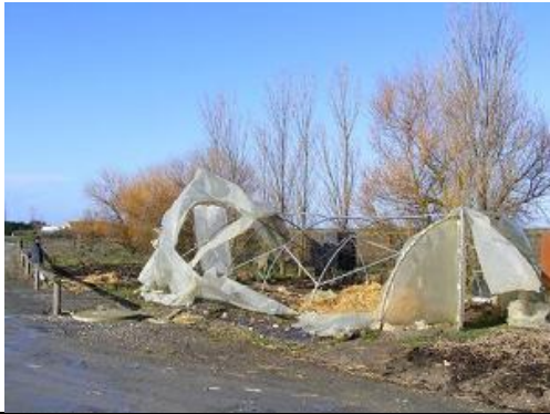
In maart raasde er een storm over van 130km/uur en woei de groentekas aan flarden.
